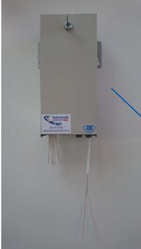
Skarvbox placeras på central plats inne i huset. Företrädevis i källaren
